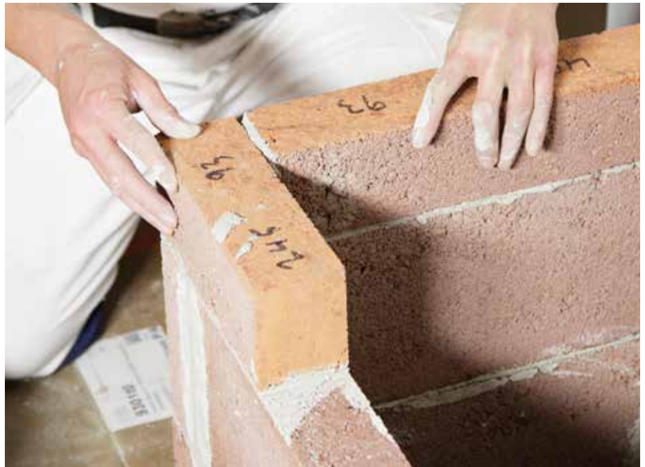
TIILERI TULISIJOJEN VALMISTUKSESSA KÄYTETÄÄN EKOLOGISTA LÄMPÖKIVEÄ.
