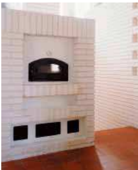
Sisäänvedetty suorasauma, tiili Ruukintiili vaalea.
